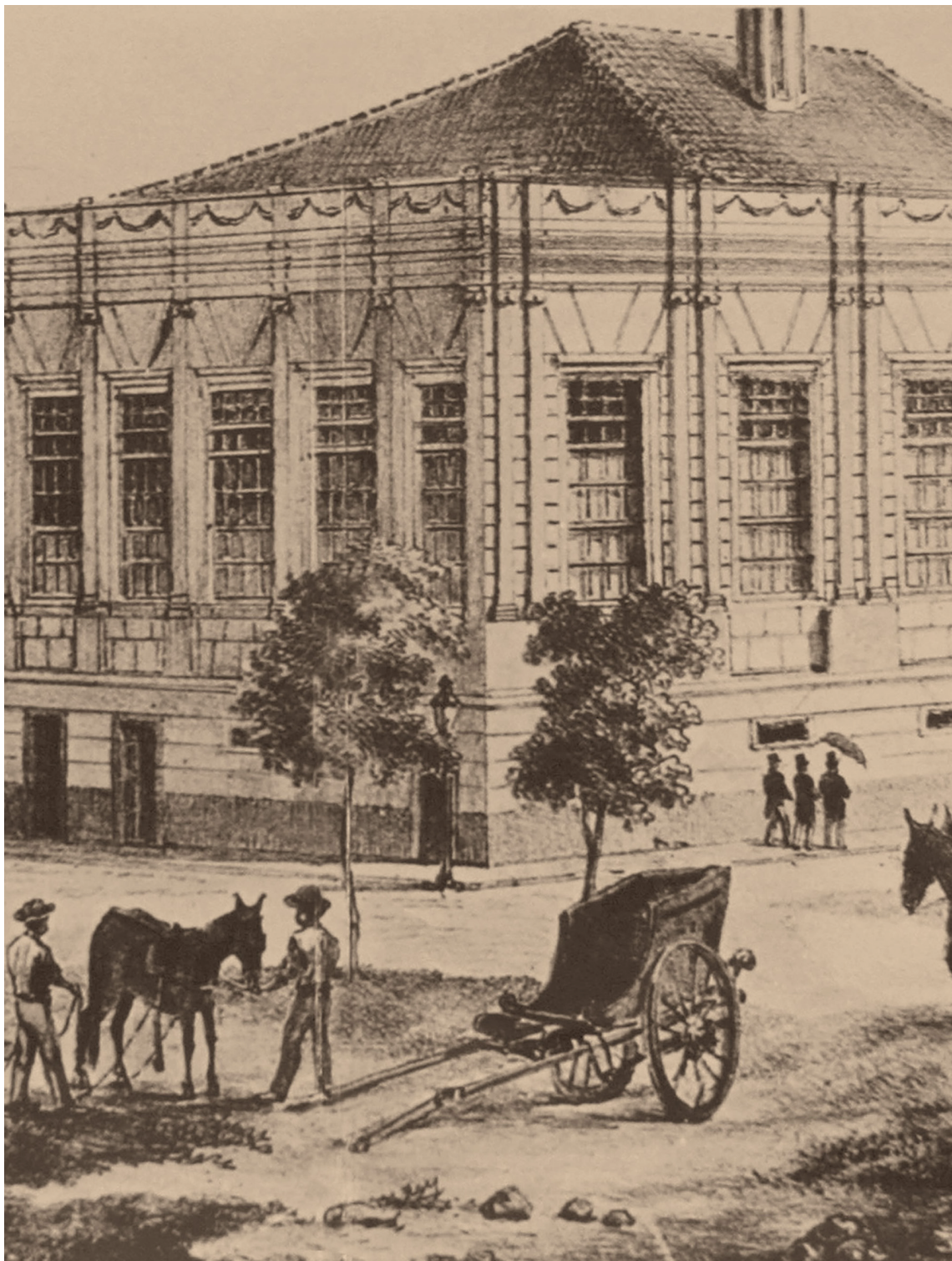
Palácio do Conde dos Arcos, prédio onde funcionou o Senado Durante o Império e sede provisória do Supremo Tribunal de Justiça, criado pela Constituição de 1824. Autoria: Pieter Godfred Bertichen
